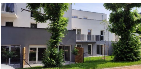
Résidence Le Mistral à Lempdes 32 logements (2023) Architecte : îlot architecture
