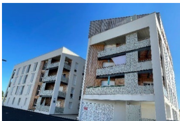
Résidence Oppida Cournon-d'Auvergne 25 logements (2020) Atelier d'architecture CASA
